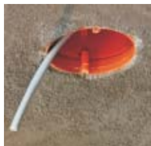
Doza KBT...cu conductor scos și pregătit pentru candelabru KBP...
