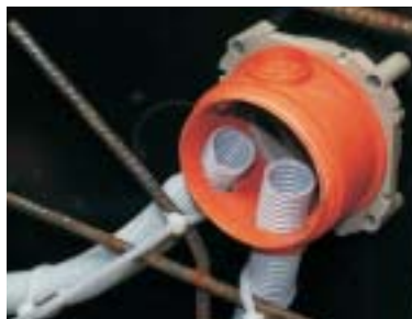
Tuburi flexibile montate în corpul KBT.
