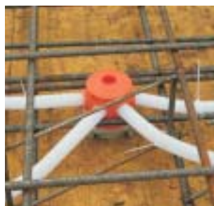
Exemplul de folosire pentru cofraj orizontal.
