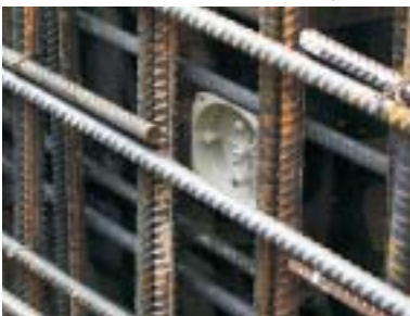
Capacul KBV fixat pe cofraj.
